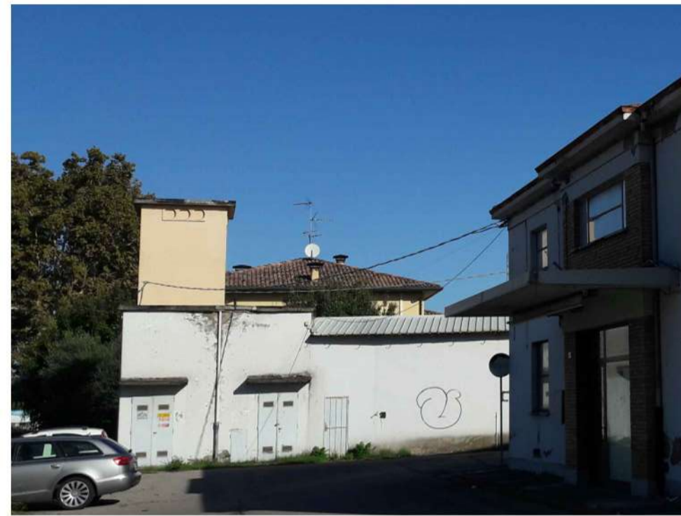
VISTE ESTERNE FABBRICATI
